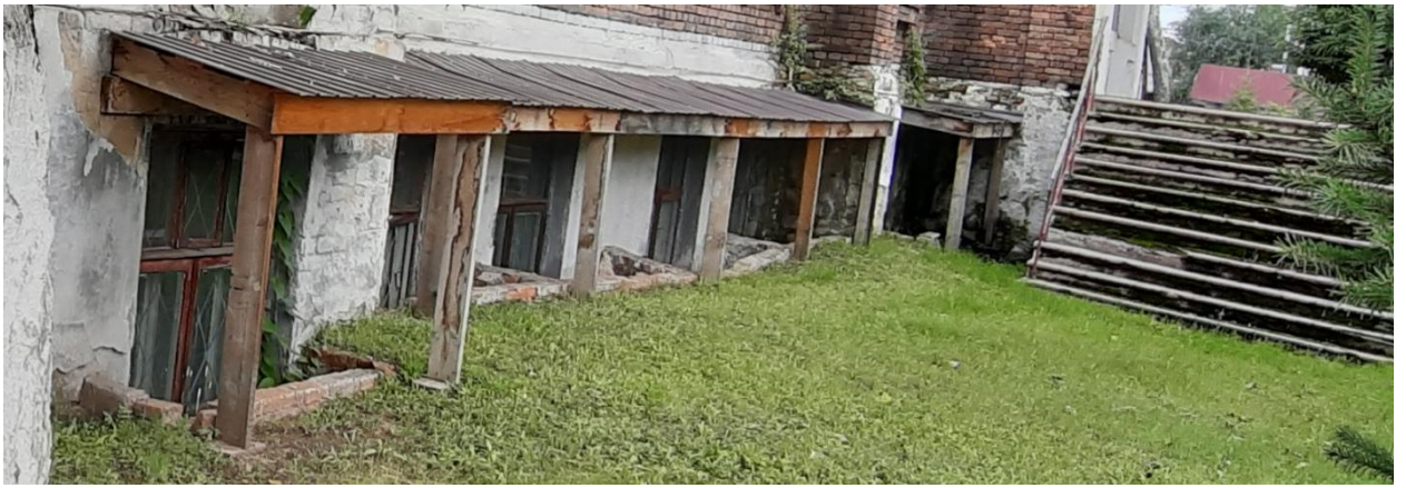
Приямки главного фасада
