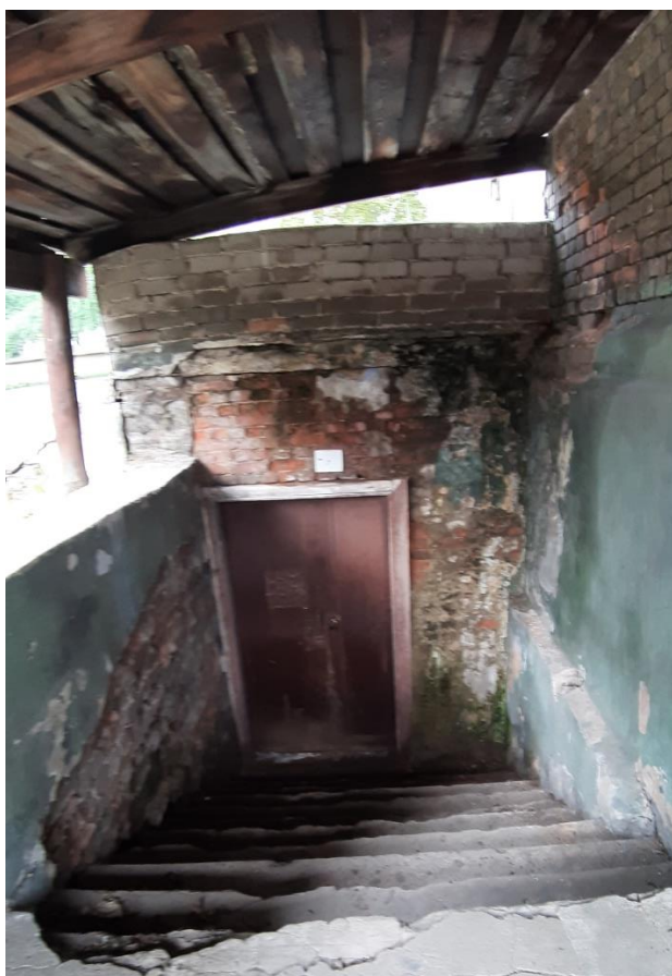
Северо-западный фасад. Вход в подвал.
