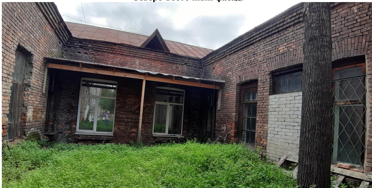
Северо-восточный фасад между средним и восточным крыльями.
